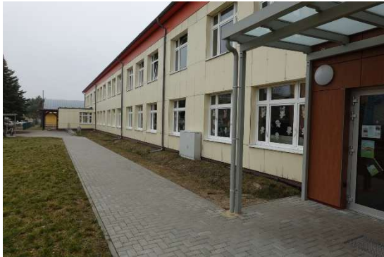
Abb. 1: östlicher Grundstücksbereich zwischen Schulgebäude und Artur-Becker-Ring mit nördlicher Blickrichtung
